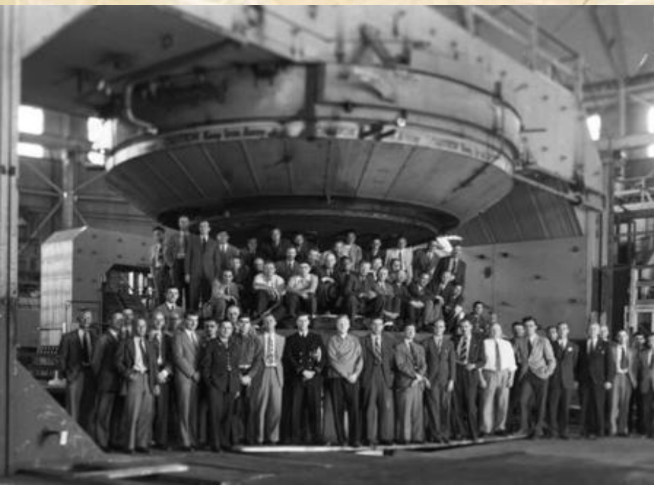
184インチサイクロトロン用電磁石
